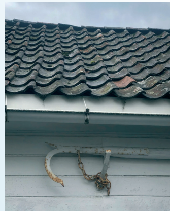
Рис. 9. Інструмент для розбирання частин дерев'яної панелі або конструкції. Джерело: Норвезький інститут досліджень культурної спадщини
