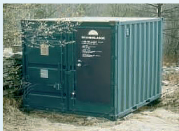
Рис. 12. Пожежна міністанція, яка має джерело води, у Норвегії
